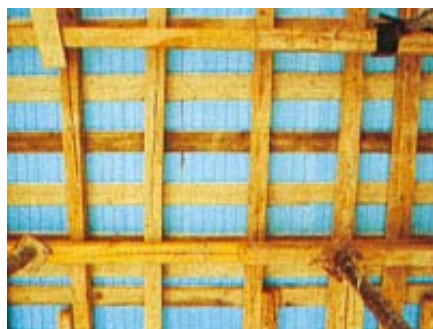
Αποψη ξυλότυπου (άνοψη)
