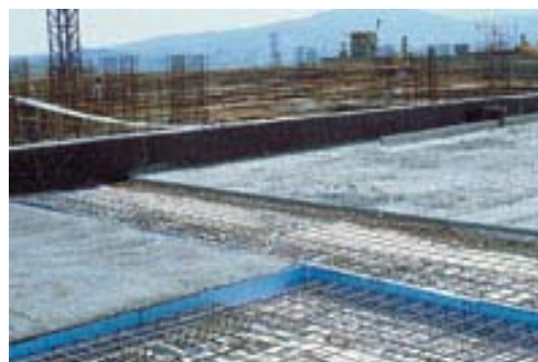
Αποψη σιδηροπλισμού (κάτοψη)
